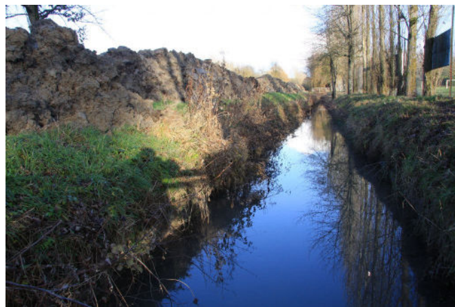
Recalibrage d'un cours d'eau
