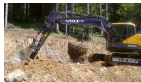
Travaux route forestière
