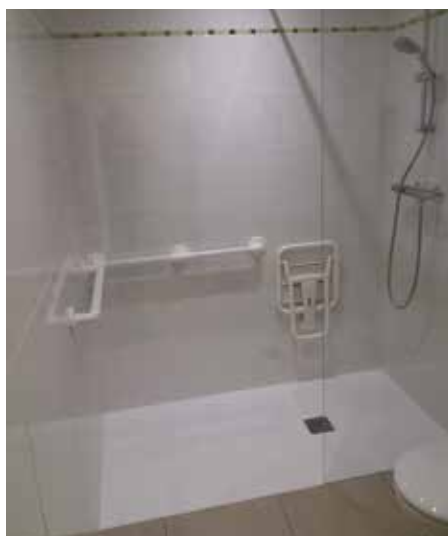
Douche à l'italienne avec mitigeur thermostatique, barre de maintien et siège
