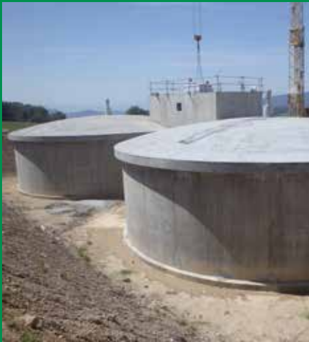
Réservoir d'eau en construction
